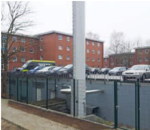
Parkhaus Saxtorfer Weg, Foto: Stadtwerke Eckernförde
